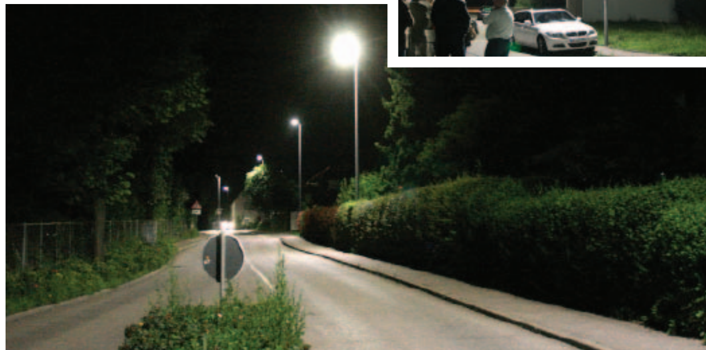
Spezielle optische Linsen in Verbindung mit CREE-LED-Modulen der jüngsten Generation ermöglichen eine gleichmäßige Ausleuchtung ohne gefährliche Dunkelfelder.
